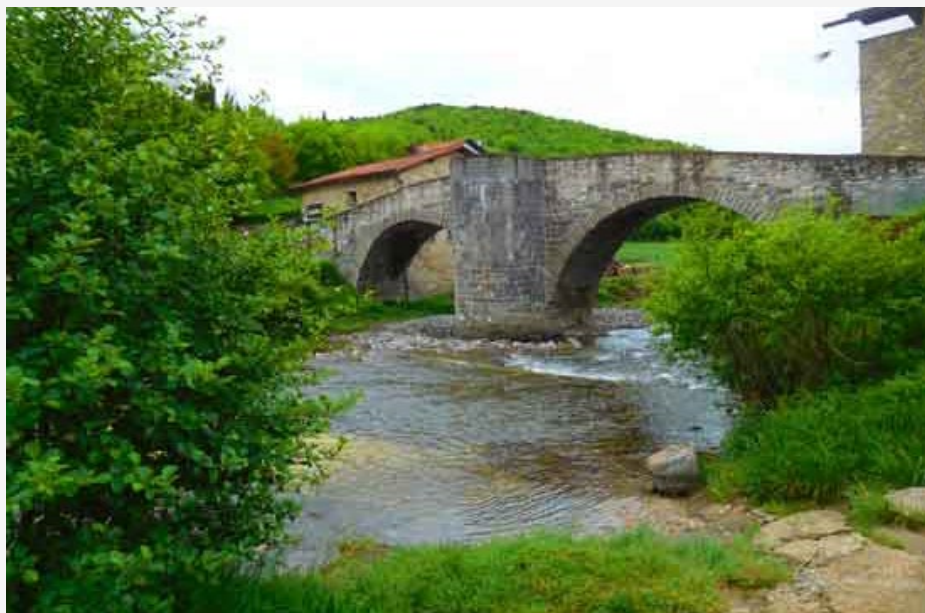
Zubiri. Il ponte della “Rabbia” sul fiume Arga.
